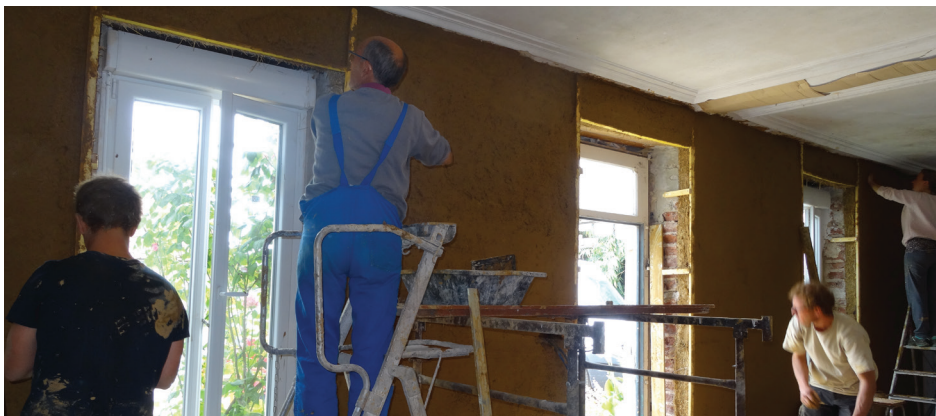
Le stage participatif : durant une journée, le chantier a été ouvert à des particuliers bénévoles désireux d'apprendre des techniques écologiques de rénovation. Encadrés par l'artisan Benoit Devin, ils ont pu découvrir et mettre en pratique la pose d'un enduit en terre et copeaux de bois dans une ambiance conviviale.
