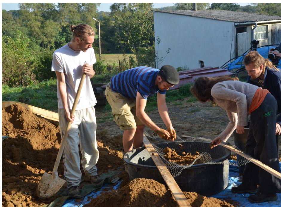
Le stage participatif : durant une journée, le chantier a été ouvert à des particuliers bénévoles désireux d'apprendre des techniques écologiques de rénovation. Encadrés par l'artisan, Hervé Bodard, ils ont pu découvrir et mettre en pratique l'enduit à caractère isolant terre-anas de lin dans une ambiance conviviale.
