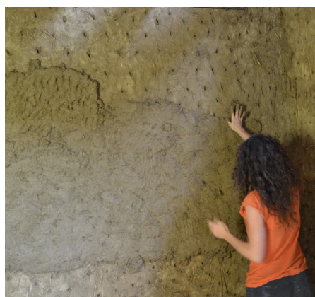
Pose de la première couche d'enduit en septembre 2016.
