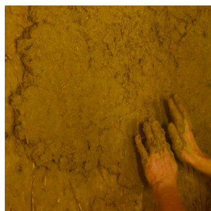
3. Répartir légèrement la matière avec les mains. Une fois que la première couche sèche en surface, renouveler les opérations 2 et 3.
