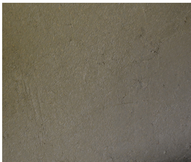
5. L'enduit a été serré avant séchage. Il recevra ultérieurement une peinture à l'argile colorée (un badigeon ou une autre peinture naturelle pourrait être également utilisé).
