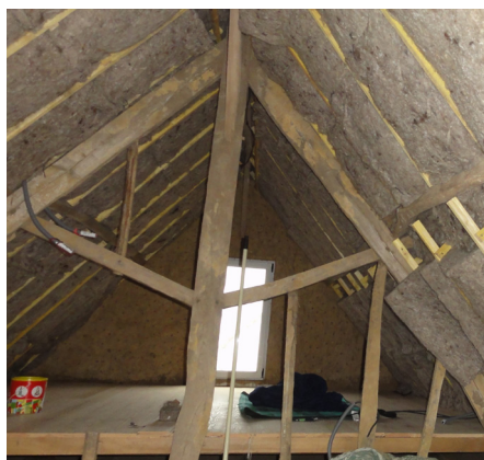
La laine de mouton va être recouverte de canisses de roseaux enduits.
