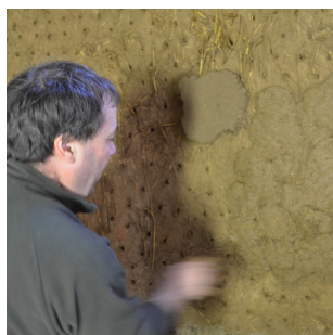
2. Technique retenue : lancer des boulettes d'enduit de taille identique les unes à côté des autres.
