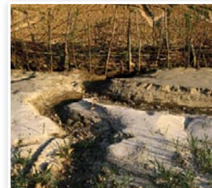
Perpendiculaires à la pente, les haies (ici fascine*) freinent le ruissellement
