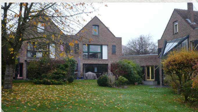
Les maisons sont **bioclimatiques** : double orientation, inertie thermique (mur masse en briques pleines), sas, serres solaires, poêles à bois, ventilation double flux.
