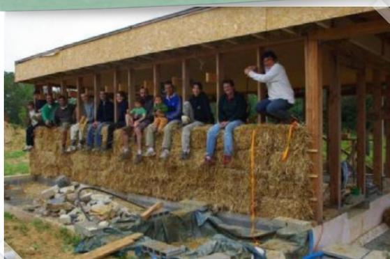
Des bâtiments passifs et BBC, avec autoconstruction de l'espace partagé : en paille, enduite de terre et une toiture végétalisée.
