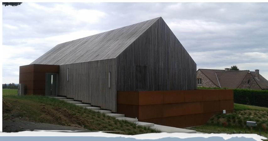
La volumétrie est simple, inspirée de l'architecture traditionnelle, avec un soubassement et des ouvertures réinterprétées.
