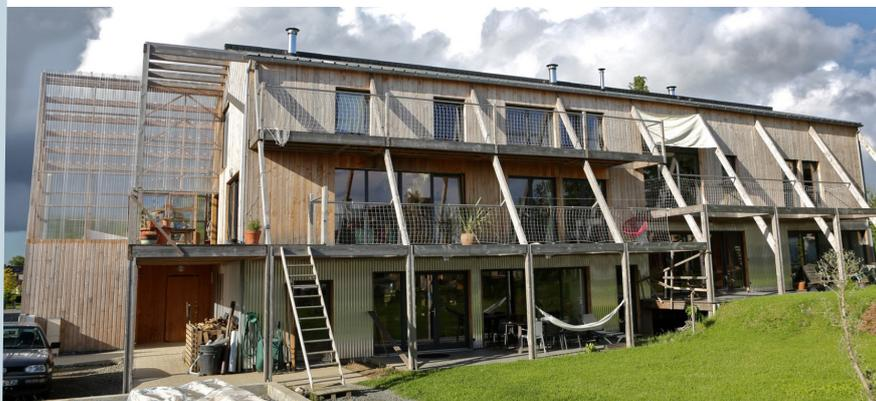
Un groupe de 4 familles se connaissant peu, s'est constitué en **SCCC (Société Civile Coopérative de Construction)** afin d'autoconstruire un petit collectif à ossature bois en R+1 plus combles, avec une isolation répartie en **ouate de cellulose et fibre/laine de bois**.
