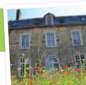
Mise en œuvre d'une démarche de certification de type EMAS pour le syndicat mixte
