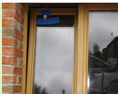
Pose de capteurs à Rinxent
