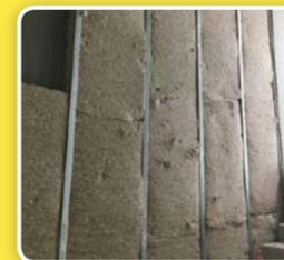
**Biofib'Trio (panneaux de chanvre, de coton et de lin)** : solution d'isolation thermo-acoustique globale. Avec une densité de 30 kg/m<sup>3</sup> et plusieurs épaisseurs proposées, ce produit peut être utilisé en combles aménagés, en isolation des murs par l'intérieur ou l'extérieur. Cet isolant apporte, en plus, un confort d'été supplémentaire pour éviter les surchauffes souvent rencontrées dans les combles.
