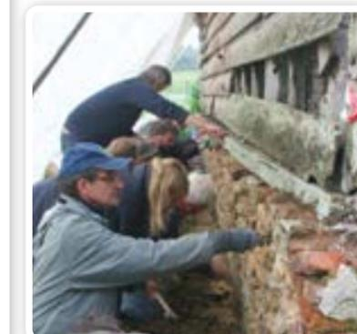
« Les briques et les pierres servaient de base à la structure, ensuite les murs étaient construits en planches de bois à clin », explique Frédéric Evard. Une quinzaine de mètres a ainsi pu être restaurée de façon écologique et durable.
