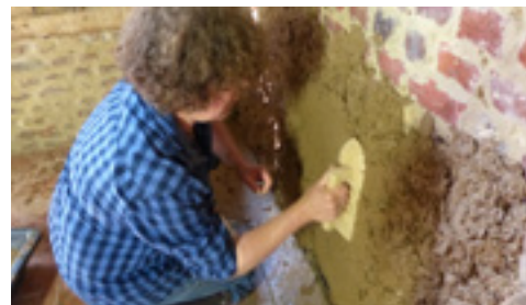
Pose de l'enduit intérieur
