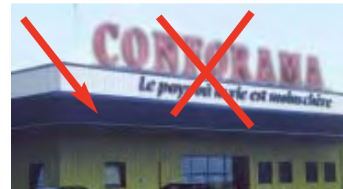
Application de la charte signalétique : enseigne sur toiture interdite: l'enseigne peut être installée sur le bandeau.
