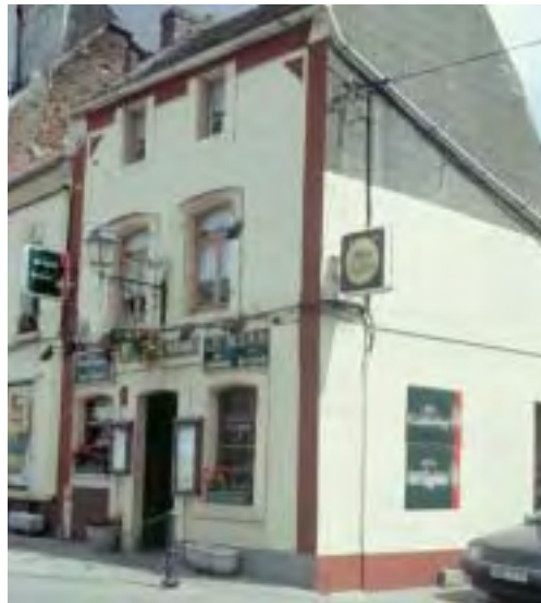
Application de la charte graphique : implantation des enseignes parallèles dans les limites du 1 er étage ; 2 enseignes parallèles par mur.
