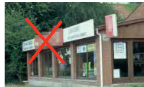
Enseigne parallèle au mur : elle ne doit pas dépasser le mur support.
