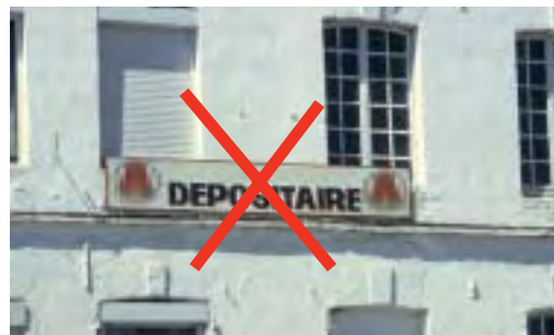
Enseigne parallèle au mur : elle ne doit pas être installée devant les ouvertures.
