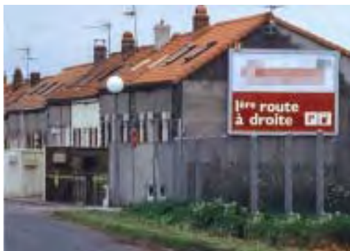
Constat : panneau de 12m 2 interdit en PNR.
