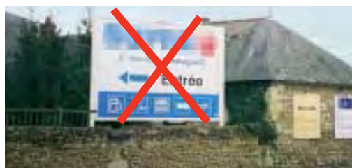
Principale infraction, enseigne scellée au sol de plus de 6m 2 .
