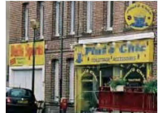
Enseignes parallèles au mur : légales mais trop importantes par rapport au bâtiment ; elles masquent la corniche.
