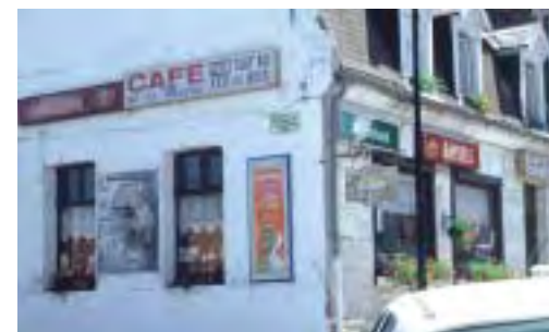
Enseignes parallèles au mur : elles sont légales aujourd'hui, mais paraissent trop nombreuses et respectent mal l'architecture du bâtiment.
