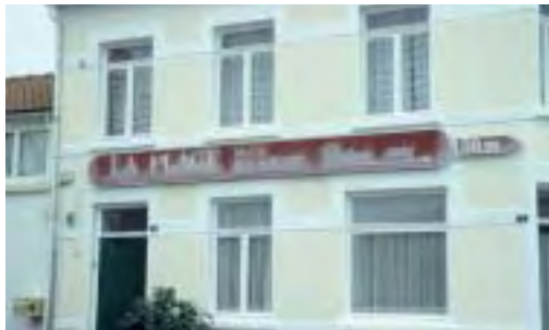
Application de la charte signalétique : l'enseigne ne masque pas la corniche et mesure moins de 0,7m de haut ; elle est alignée avec les limites des ouvertures.
