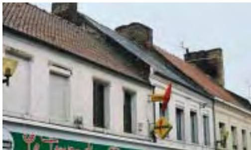
Application de la charte signalétique : enseignes perpendiculaires limitées en nombre à 2 dispositifs par commerce..
