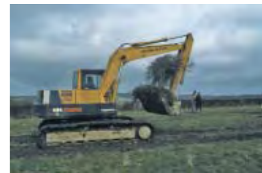
Puis les haies ont été déplacées par tronçon de 2 m de longueur à l'aide d'une pelleuse et placées dans les fossés créés au préalable à 2m de la limite de propriété.
