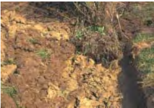
Les haies ont été ensuite reconstituées aux abords du tracé grâce à l'aménagement de fosses linéaires dans lesquelles les mottes ont été placées bout à bout.
