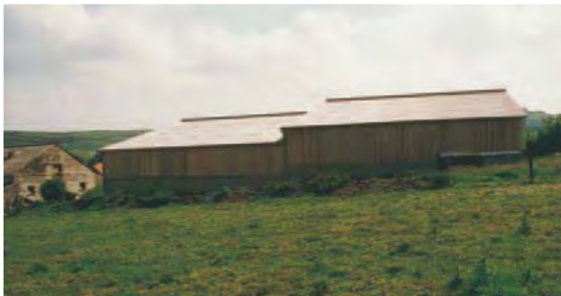
Le décalage des toitures permet de compenser l'obligation de construire dans le sens de la pente
