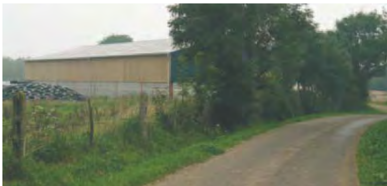
La préservation de la végétation existante permet de limiter l'impact visuel du pignon
