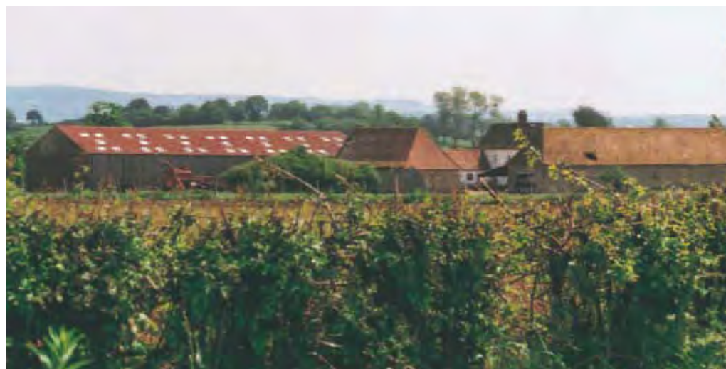
Des matériaux nouveaux qui sont en harmonie avec le bâti ancien
