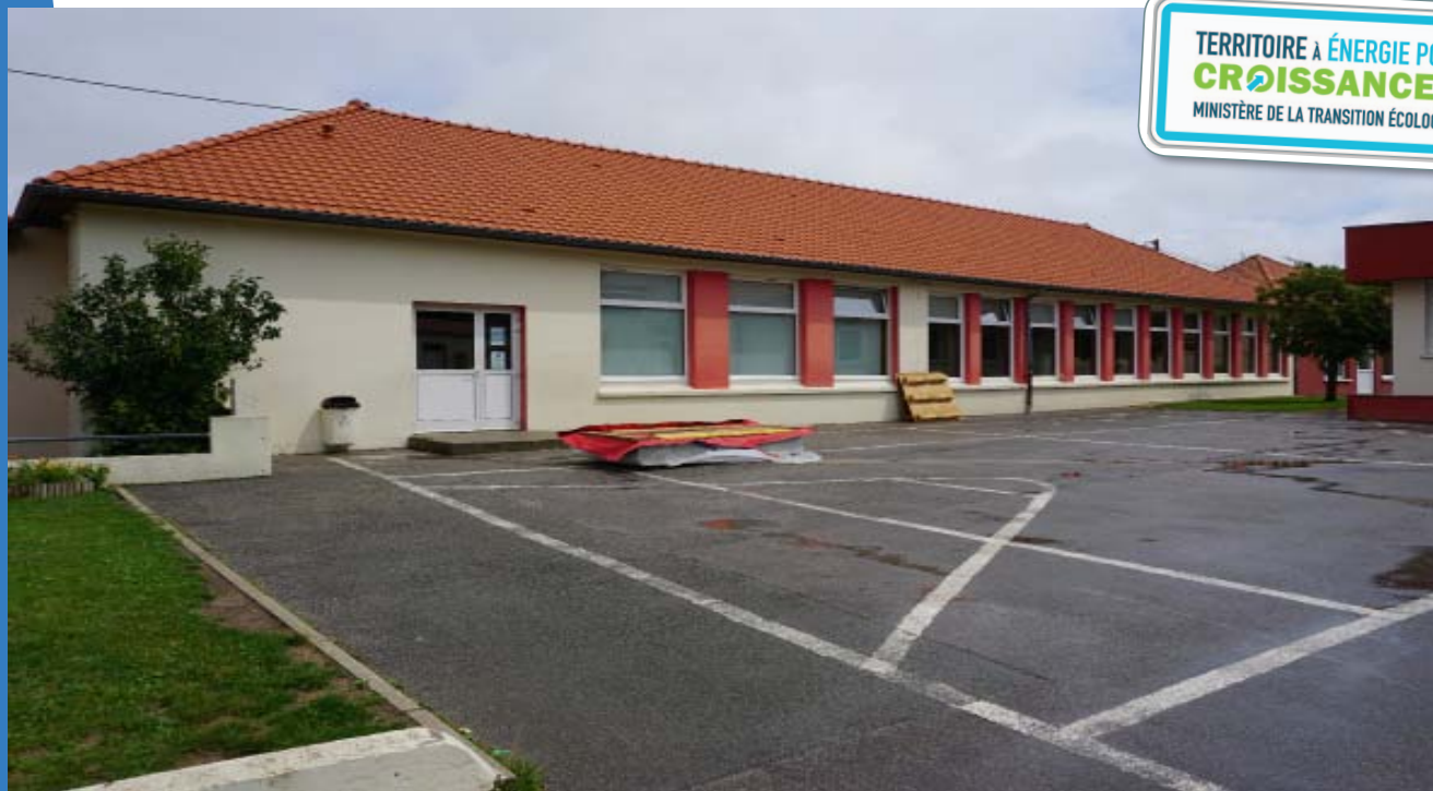
Façade de l'école.
